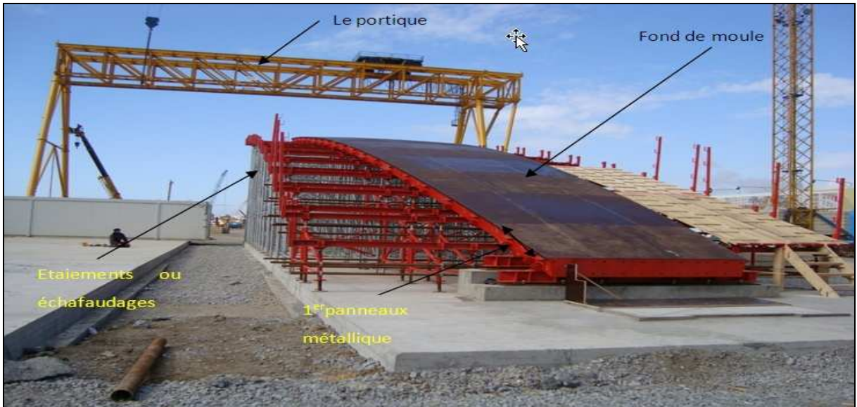
Figure 10 : Fond de moule de préfabrication d'une palme
