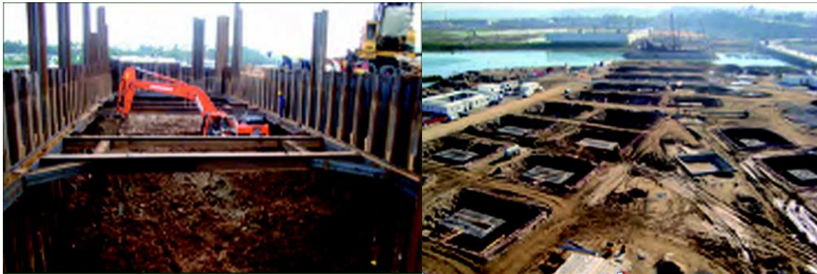
Figure 7 : Vue sur les Réalisation des fouilles semelles réalisées.
