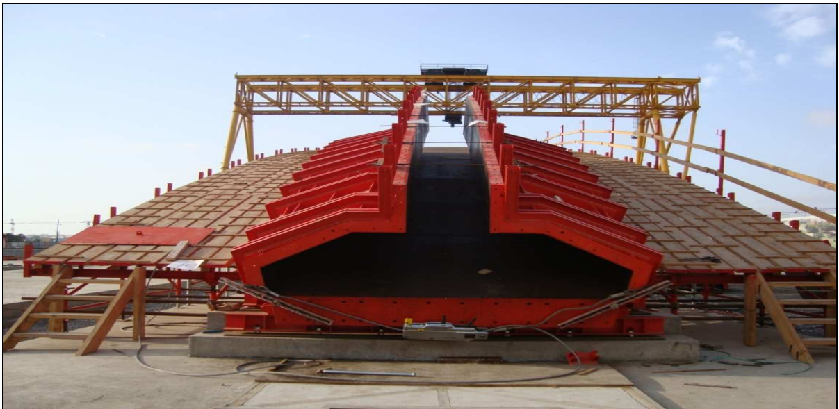
Figure 11 : Coffrage latéral d'une palme.
