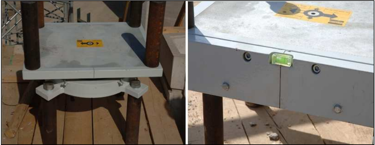
Figure 14 : Label collé au centre de l'appui et le niveau à bulle.
